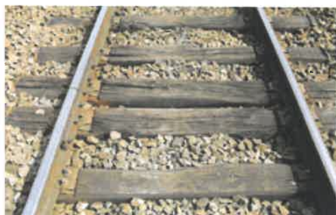
Rails courts sur traverses bois
